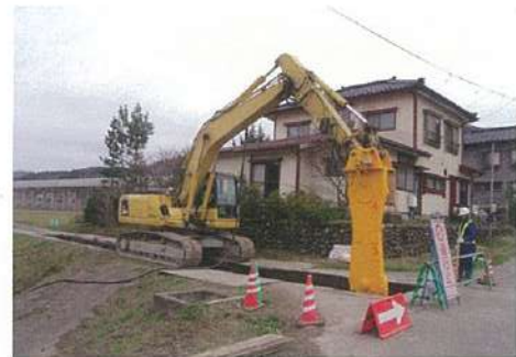
民家の近接部における改良施工
